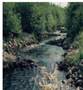
Figura 24: Estrutura para a transposição de peixes semi natural. Finlândia.
