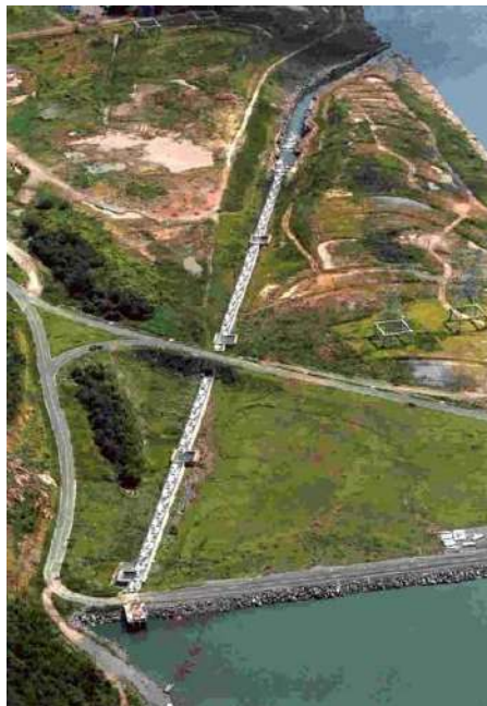
Figura 15: Visão geral da escada da UHE Lajeado no rio Tocantins.
