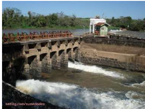
Figura 26 Usina Eloy Chaves no rio Mogi Guaçu.
