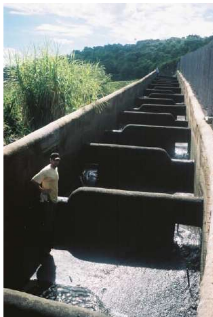
Figura 12: Degraus Tanque na escada da PCH Ourinhos. SP (visão à direita).
