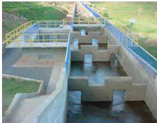
Figura 14: Soleiras da escada de UHE Lajeado no Rio Tocantins.
