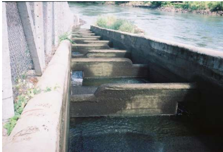
Figura 11: Degraus Tanque na escada da PCH Ourinhos.SP (visão à esquerda).
